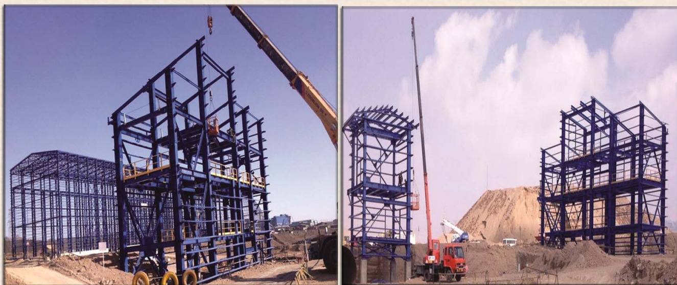
تجهیز، ساخت و نصب اسکلت فلزی پروژه کستائره سغان
