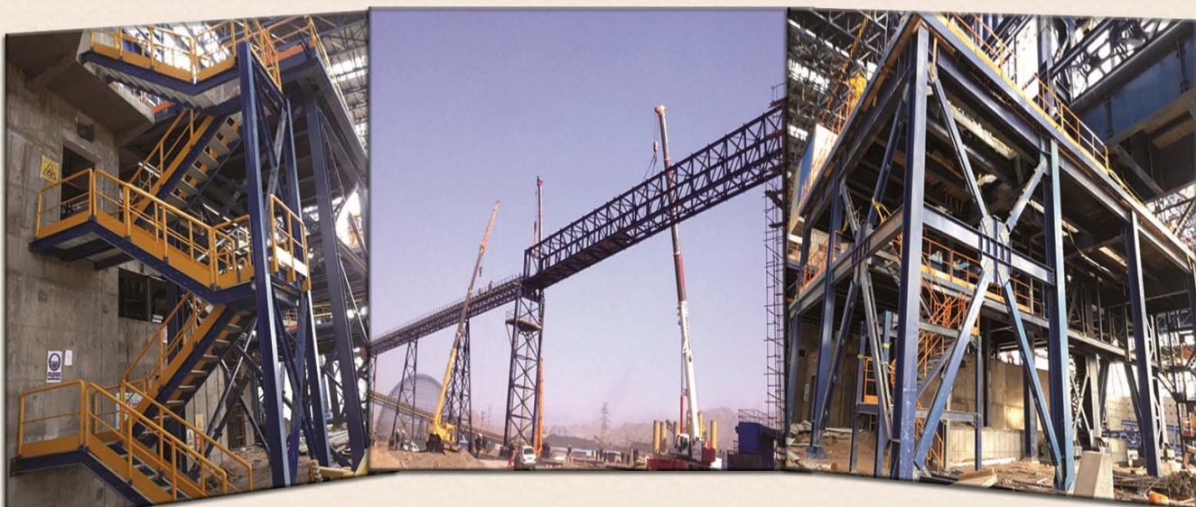
تجهیز، ساخت و نصب اسکلت فلزی EAF & LF & Pump station پروژه نوب شرکت مجتمع جهان فولاد سیرجان
